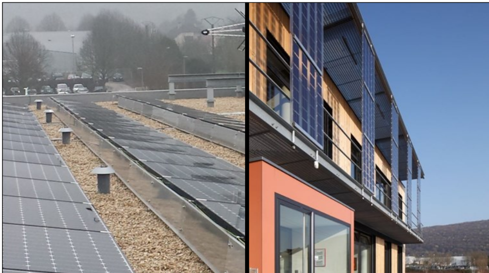
Capteurs solaires photovoltaïques en toiture et en façade du bâtiment
